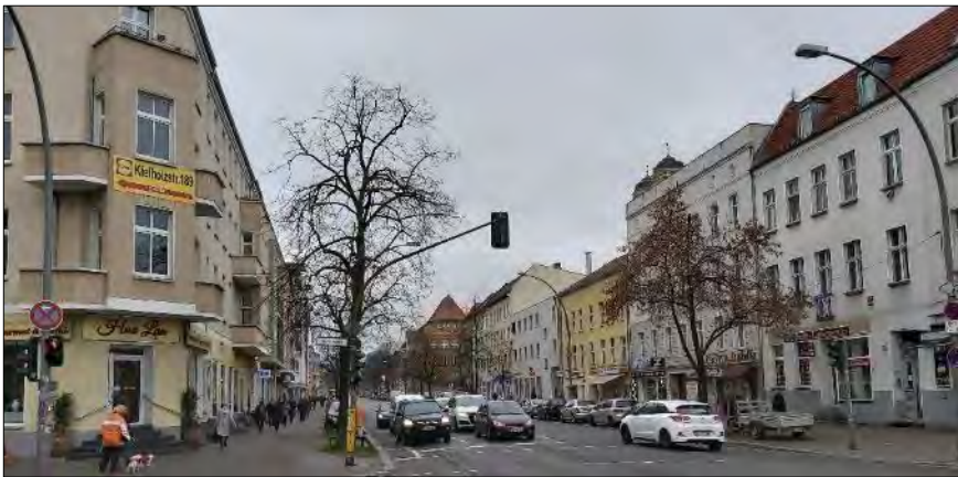
Abb. 11: Gründerzeitlich geprägte Blockrandbebauung im Ortsteilzentrum Baumschulenweg (Foto: Planergemeinschaft)
