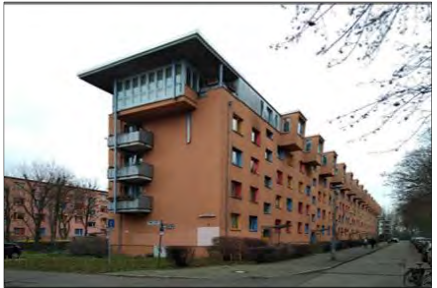
Abb. 25: Eine der wenigen Dachgeschoss-Aufstockungen der Bauserie Q3A im Fördergebiet (Bergastraße) (Foto: Planergemeinschaft)
