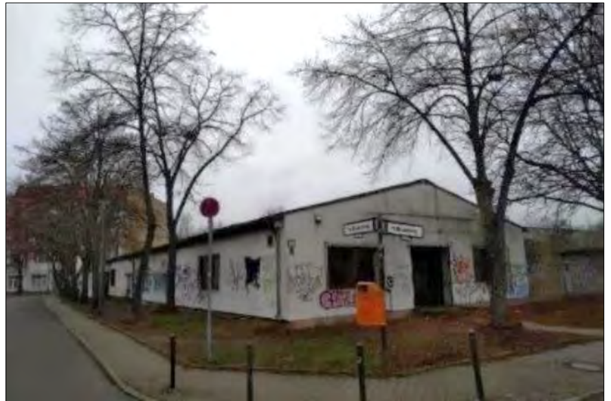
Abb. 43: Ehemaliger Drogeriemarkt am Heidekampweg (Foto: Planergemeinschaft)
