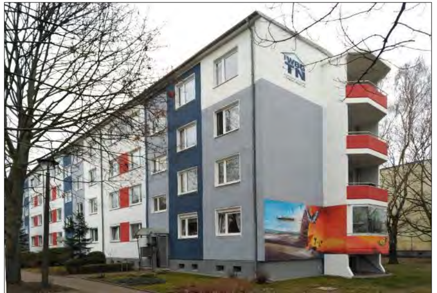
Abb. 12: Sanierter Q3A-Wohnungsbau im Ortsteil Plänterwald (Foto: Planergemeinschaft)
