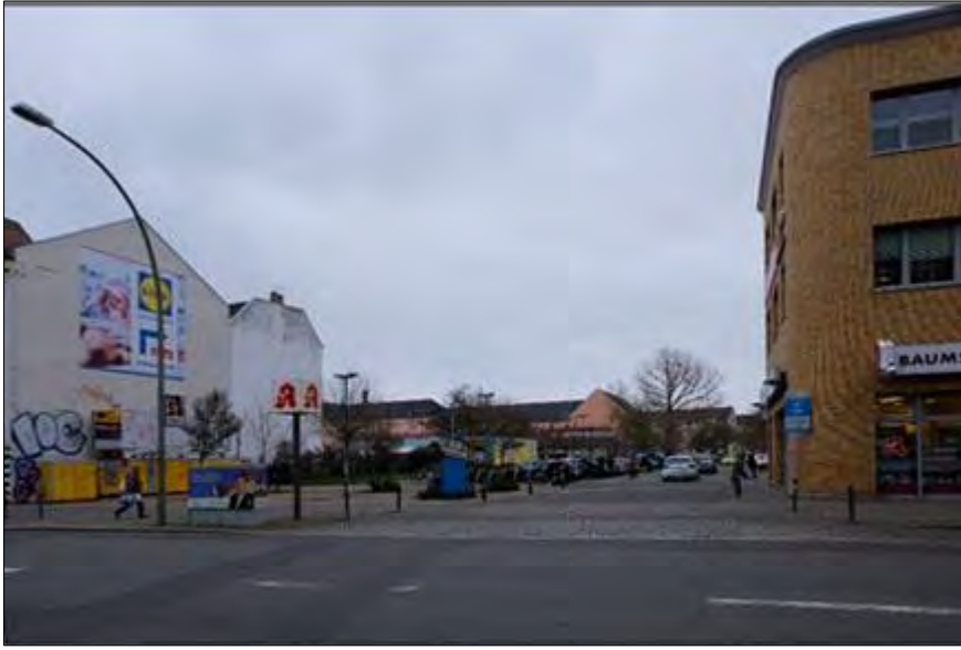
Abb. 35: Zentrumsbereich der Baumschulenstraße mit städtebaulichen und funktionalen Mängeln (Foto: Planergemeinschaft)
