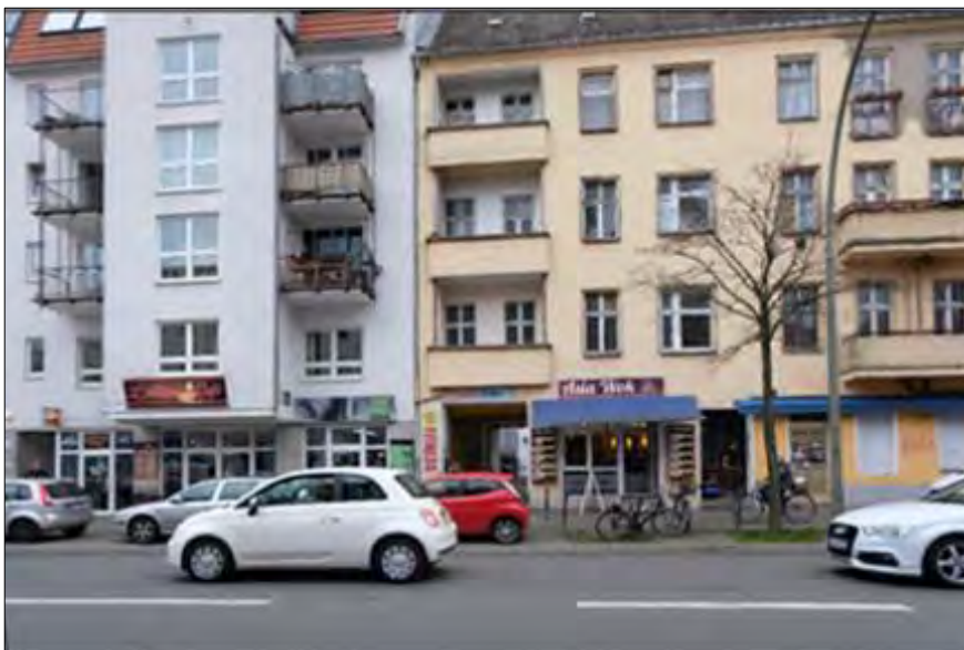
Abb. 36: Überwiegend kleinteiliger Geschäftsbesatz, schmale Bürgersteige und viel Verkehr auf der gesamten Lauflänge des zentralen Versorgungsbereichs (Foto: Planergemeinschaft)
