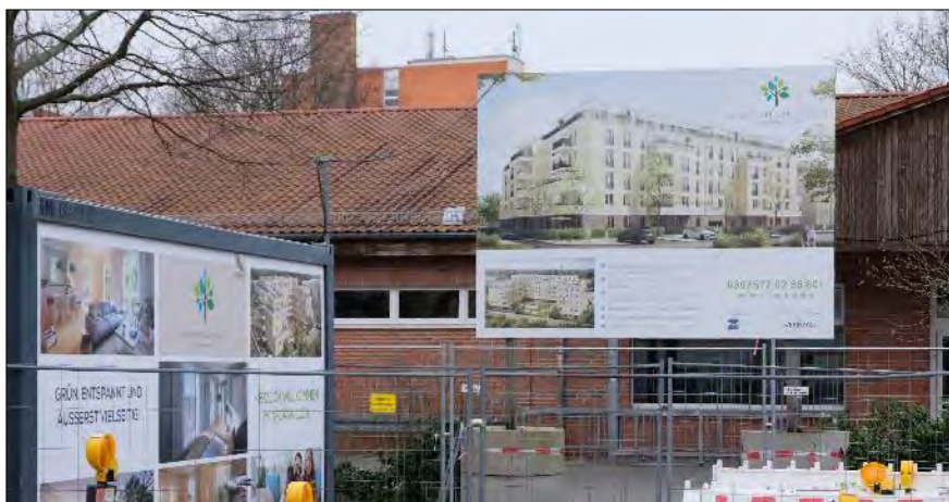
Abb. 26: Baustelle auf dem Grundstück des ehemaligen Netto Eichbuschallee (Foto: Planergemeinschaft)
