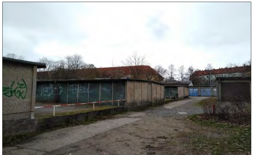
Abb. 24: Landeseigene untergenutzte Grundstücke bieten kostengünstiges Potenzial für die Schaffung von bezahlbarem Wohnraum und sozialer Infrastruktur (Foto: Planergemeinschaft)
